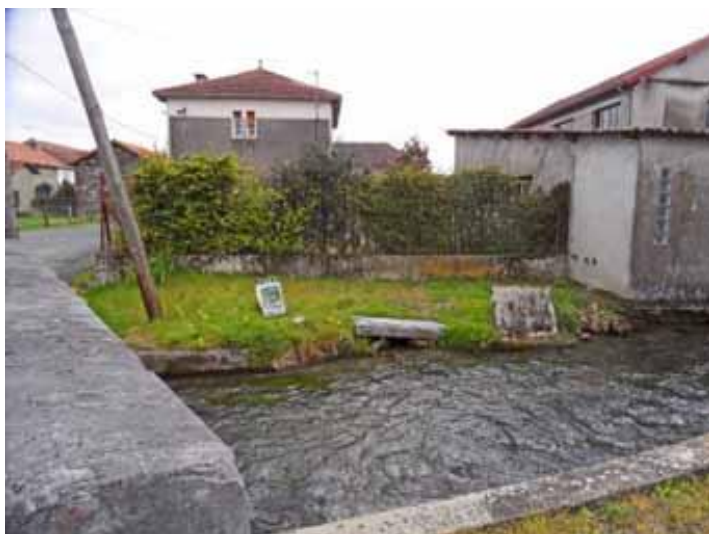
Le lavoir avant les travaux
