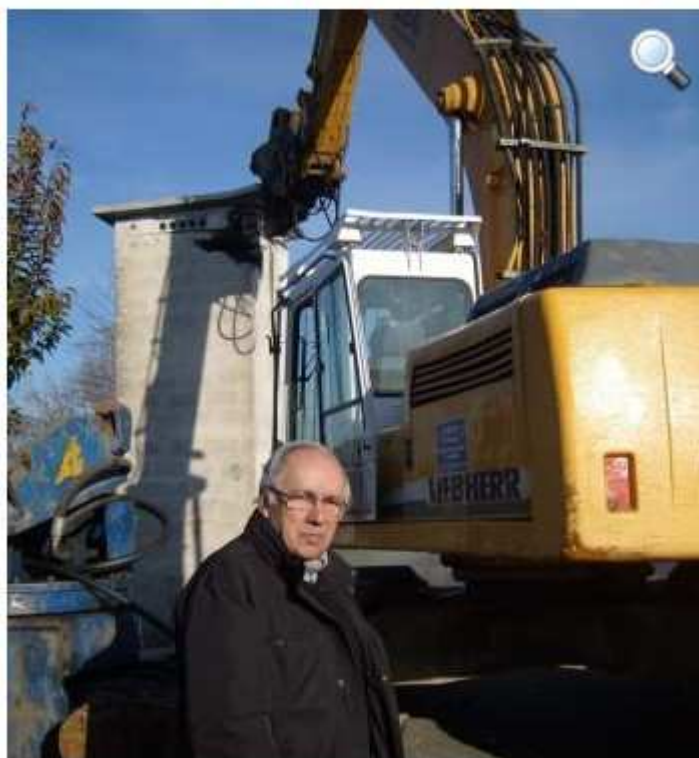
M. le maire attentif à la démolition./Photo J. M.
